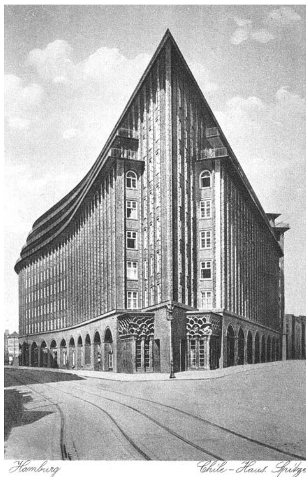
Figura 34. El edificio Chile-Haus de Hamburgo, con su aspecto de proa de barco. El transporte de salitre por mar fue una de las actividades que enriqueció a Sloman, su propietario. Tarjeta postal de 1929.
