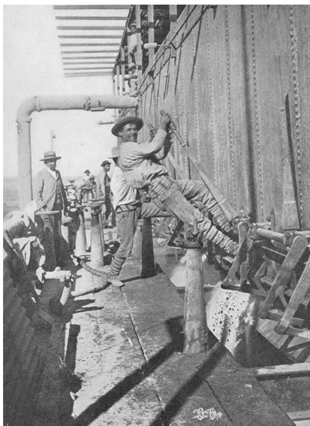
Figura 28. Obrero cargando caliche en un cachucho. Puede observarse el peligro del sistema de trabajo, con los huecos sin protección. Otros modelos eran incluso más peligrosos. Anónimo (1910).
